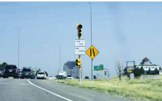
Beispiel für die Anordnung von Zwei- und Dreikammersignalgebern einer Anlage zur Zuflussdosierung in Denver, USA
