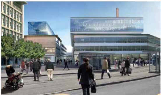
Gebäudekomplex Sihlcity Quelle: www.sihlcity.ch/de/ueberuns/bilder.html (30.11.2004)
