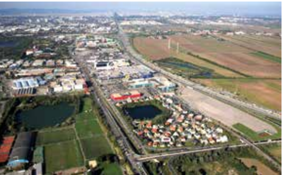
Luftbild vom Gelände der SCS Quelle: Unibail-Rodamco Austria Verwaltungs GmbH
