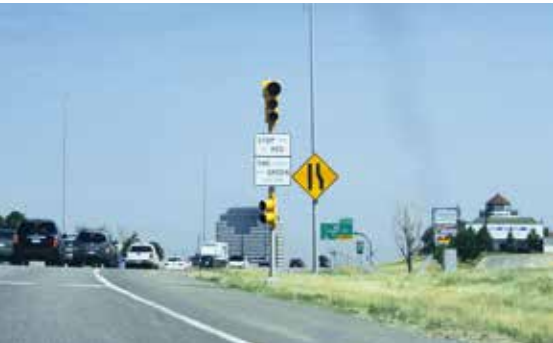
Beispiel für die Anordnung von Zwei- und Dreikammersignalgebern einer Anlage zur Zuflussdosierung in Denver, USA Quelle: Eigene Aufnahmen
