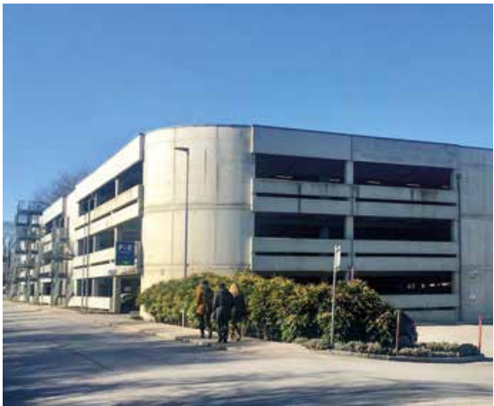
Anlage Stockerau Quelle: eigene Aufnahme
