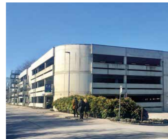
Anlage Stockerau Quelle: eigene Aufnahme
