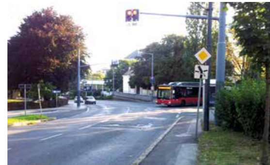
Signalregelung mit Wartezeit „Null“ und Rot-Gelb-Signalgeber („Busschleuse“ im Kreuzungsbereich Chimanistraße, Cottagegasse und Hans-Richter-Gasse, Wien)
