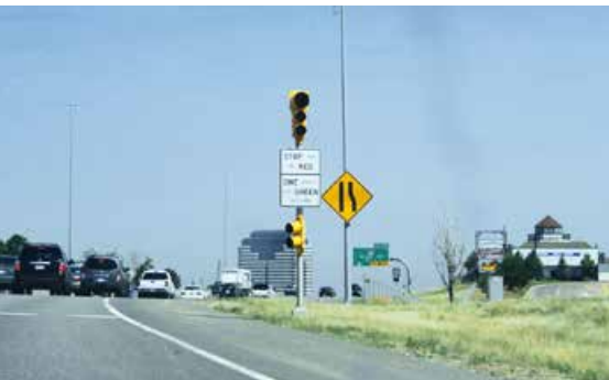
Beispiel für die Anordnung von Zwei- und Dreikammersignalgebern einer Anlage zur Zuflussdosierung in Denver, USA Quelle: Eigene Aufnahmen
